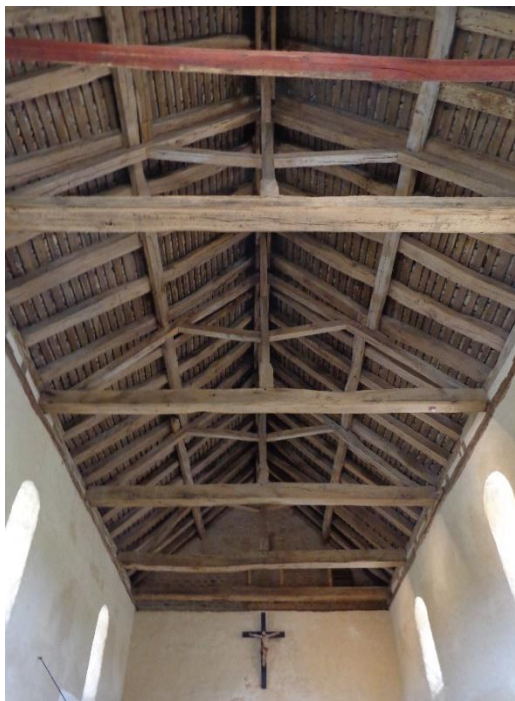
Charpente en chêne, édiflée au XIIIe, modifiée au XVe
